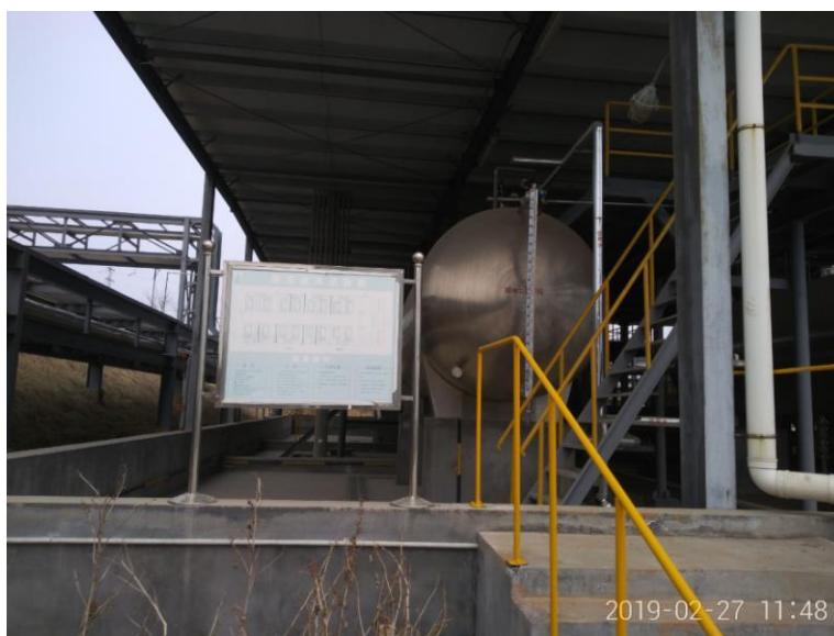
图 8.2.4-2 罐区围堰及排水沟
